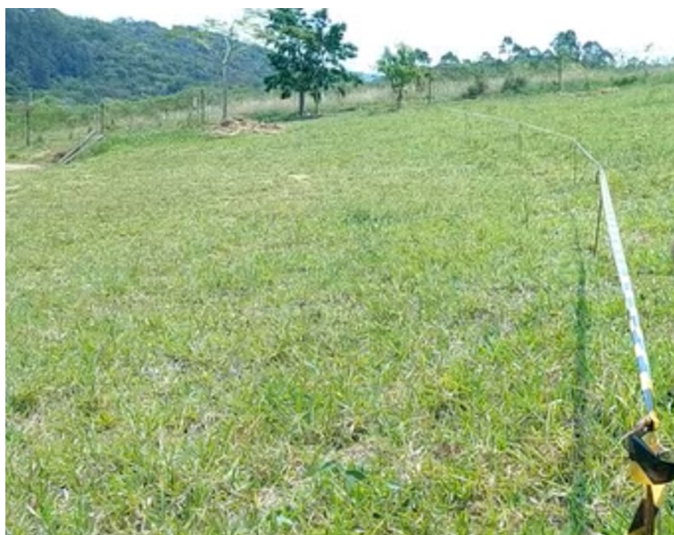
Figura 5.12. Exemplo de nível de térreo marcado.
